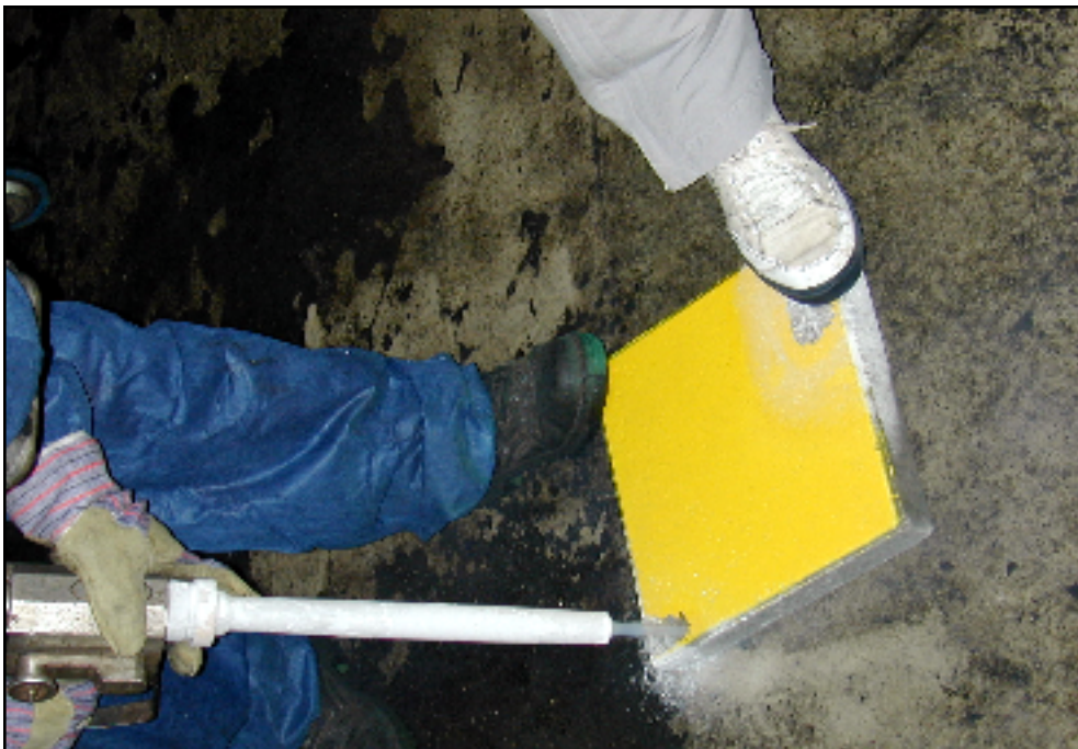
Abbildung 41: Entschichtung durch CO 2 -Strahlen
